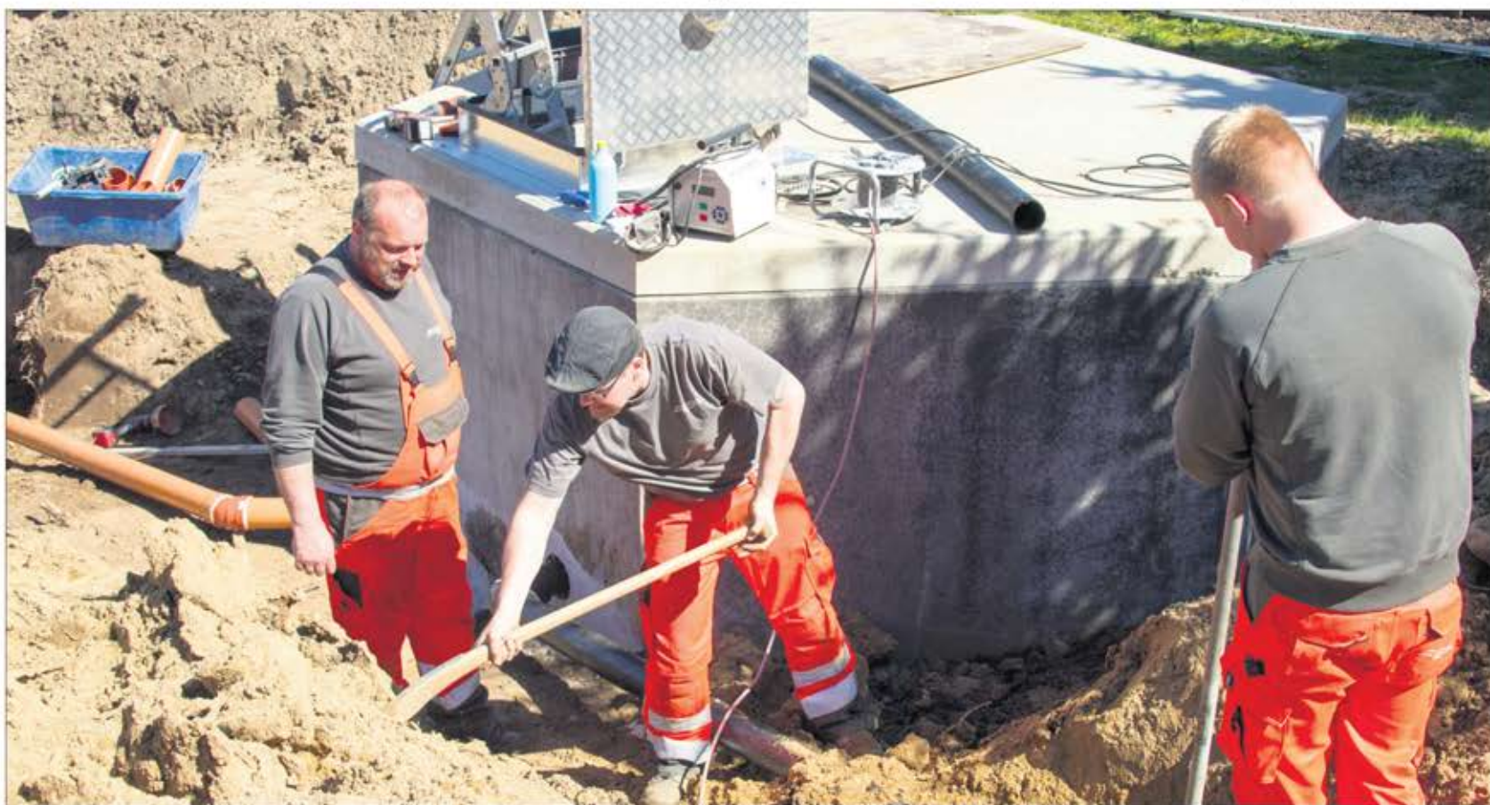
Allerede få år efter starten i 1990 var medarbejderstaben oppe på 4-5 medarbejdere. Det er der også i dag, og altid har der været en lærling i blandt. Her er folkene i gang med en opgave i forbindelse med byggeriet af et nyt vandværk i Ølholm.
